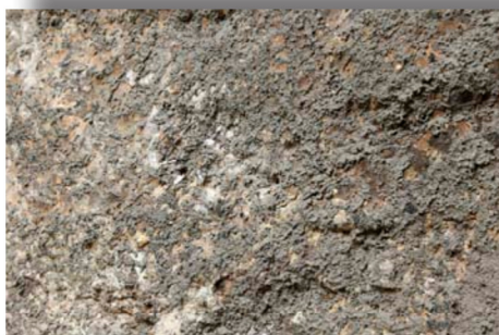
Kandke pinnale ca 50% kattetihedusega nakkekrohv SBW.
