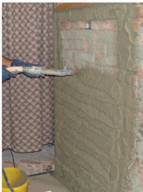
Kivistunud ja kuivale nakkekihile kanda aluskrohv. Aluskrohvile kanda peale saneerimiskrohv.
