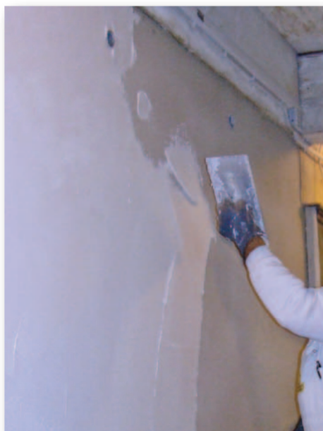
Viimistlege saneerimiskrohv mineraalse viimistlusmaterjaliga ning värvige silikaat- või silikoonvaikvärviga.
