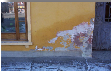
Eemaldage kahjustusega krohv ning krohv selle ümber u. 80 cm ulatuses. Puhastage müüritise vuugid kuni 20 mm sügavuselt.
