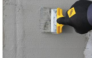
Hidroizolācija ir paredzēta uzklāšanai divos slānos. Otru slāni uzklāj ne ātrāk kā pēc 4-6 stundām pēc pirmās kārtas sacietēšanas perpendikulāri pirmajam slānim.
