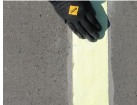
Betona grīdās deformācijas šubes pārkļāj ar deformācijas lento SAKRET D, to iestrādājot hidroizolācijas starpslāni.
