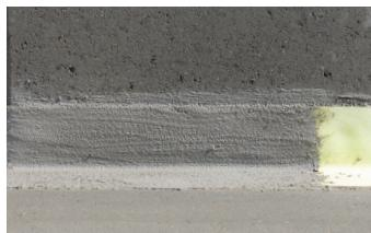
Iestrādājot hidroizolāciju balkonos un terasēs, sienas un grīdas savienojuma vietas papildus blīvē ar lento SAKRET D, to iestrādājot hidroizolācijas starpslāni.
